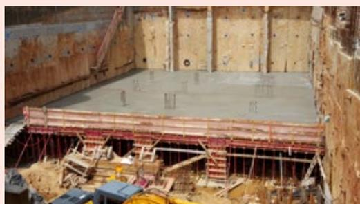
Figura 2. Trecho da primeira laje concretada.
